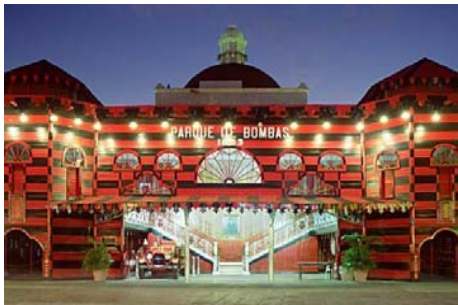
Parque de Bombas Ponce
